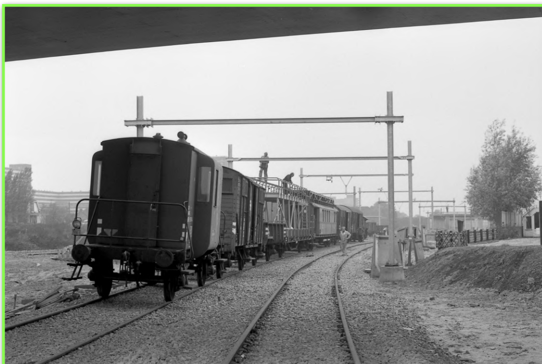
Afbeelding 8b. Aanleg van de Zoetermeerlijn: een werktrein voor elektrificatiewerkzaamheden op de aftakking richting Palenstein nabij het station Centrum West (Foto F.J. Hoevenagel, 19-10-1976) 141 .
