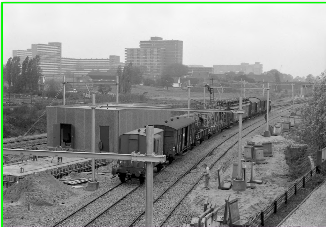
Afbeelding 8a. Aanleg van de Zoetermeerlijn: een werktrein voor elektrificatiewerkzaamheden aan het begin van de aftakking richting Palenstein nabij het station Centrum West. Links een onderstation in aanbouw (Foto F.J. Hoevenagel, 19-10-1976) 140 .
