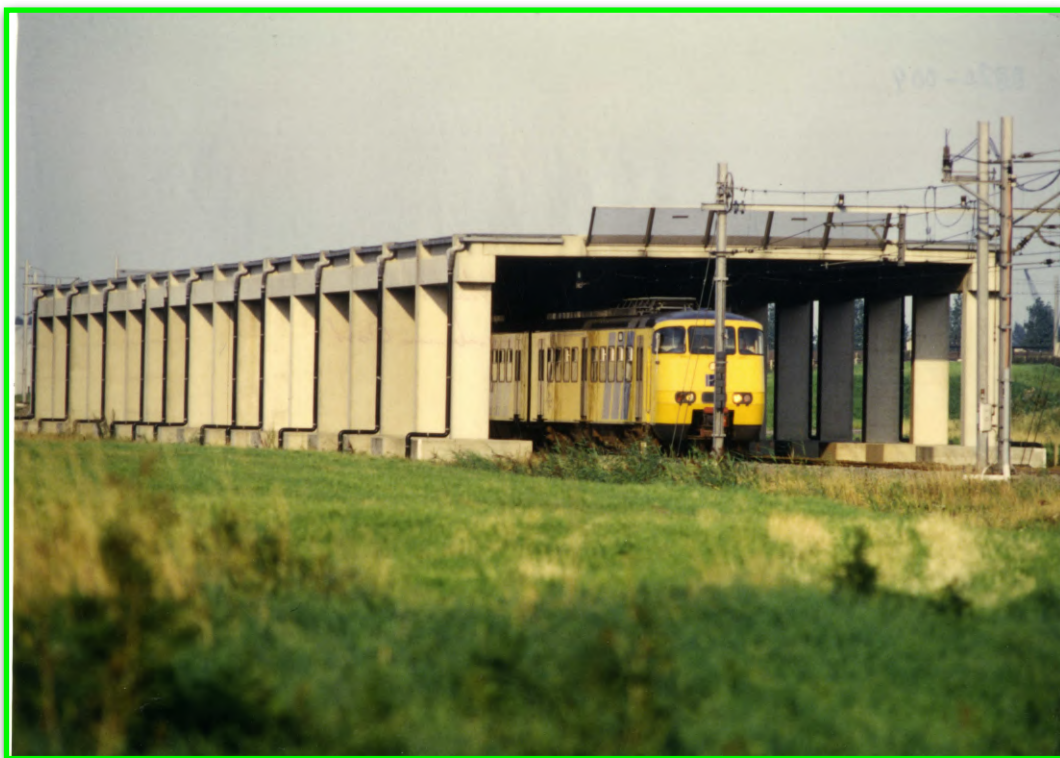
Afbeelding 18. Station Centrum Oost (later Stadhuis) (1977-1980) 188 .
