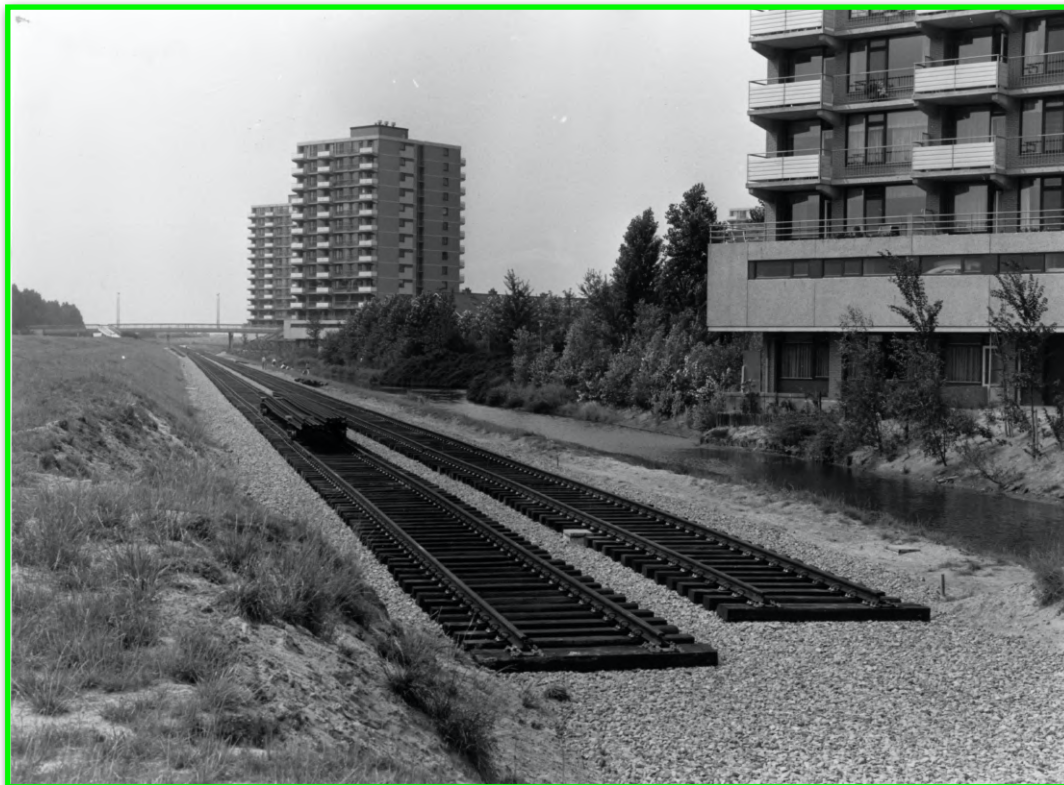
Afbeelding 7. Aanleg van het spoor tussen de toekomstige stations Dorp en Delftsewallen (1975-1977) 139
