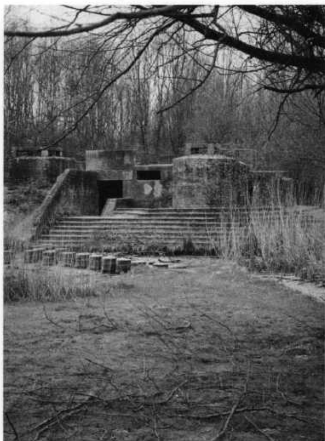
De bunker achter de boerderij van W. Vis, Voorweg 125. Het bouwwerk maakt nu deel uit van een speeltuin in het Westerpark (foto: T. Vermeulen).
