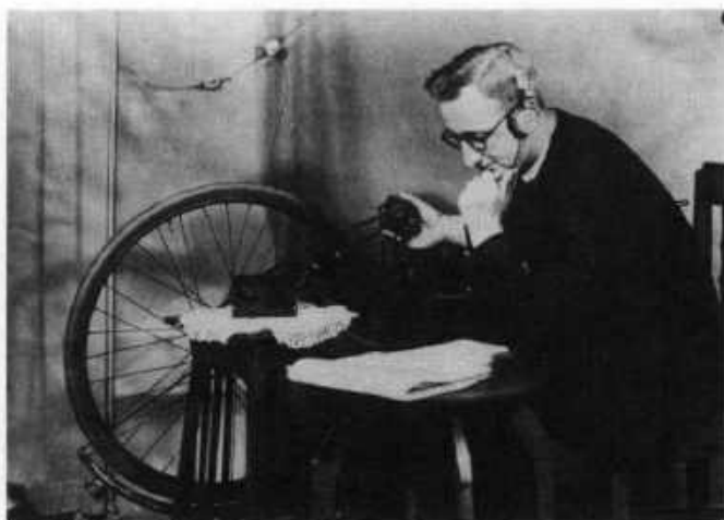
Luisteren naar Radio Oranje of de BBC. Het draaien aan de trappers van de fiets was nodig om met de dynamo elektriciteit op te wekken voor de radio.
