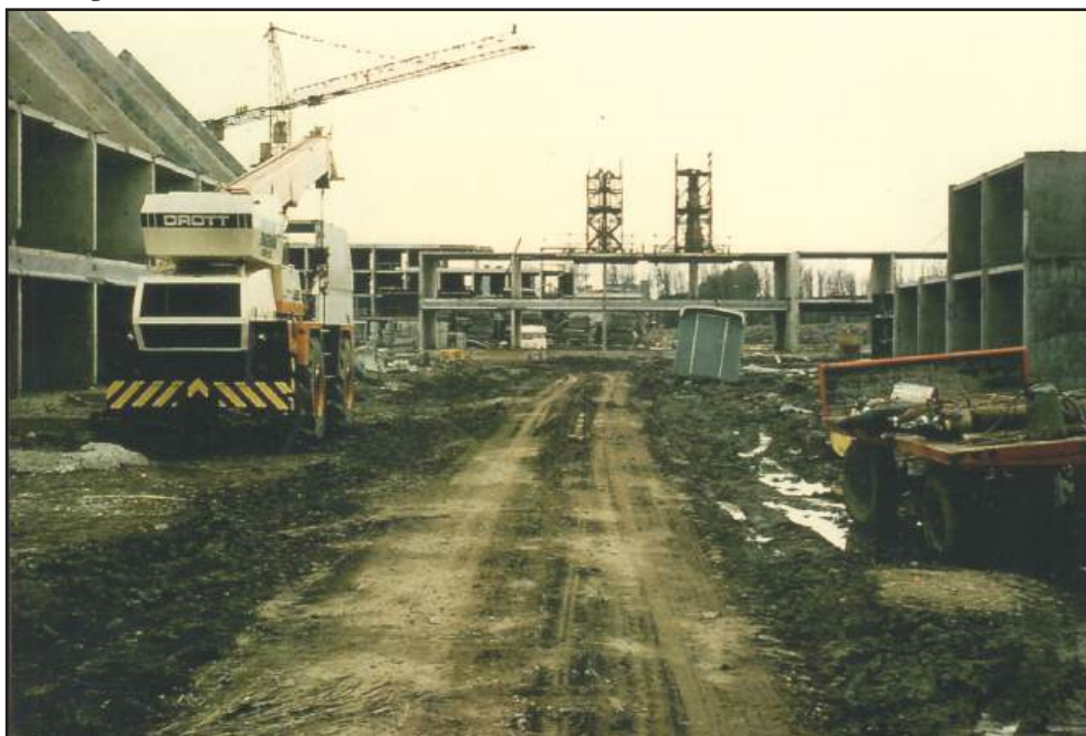
Woningen aan de Bunuelstrook in aanbouw, 1978 (Foto Dick de Kler).
