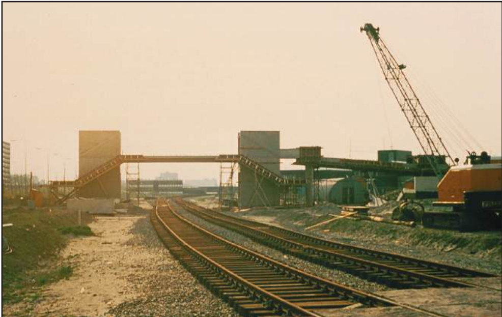
Station Palenstein in aanbouw, 1976 (Foto J. du Clou).
