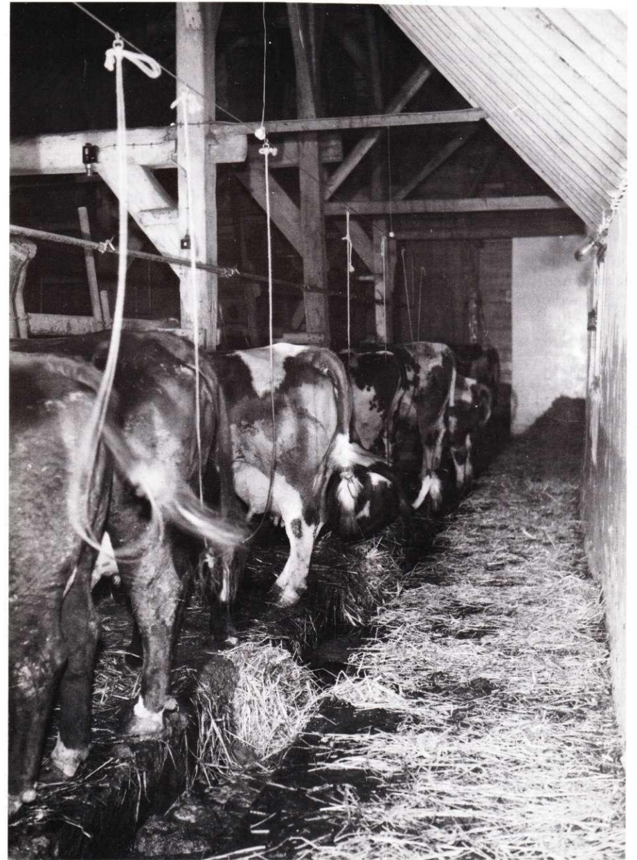
De stal in de richting van het woonhuis. De koeien staan op de Hollandse manier opgesteld: de koppen zijn naar de centrale voergang gekeerd en de gier en mest vallen in de grup die achter de koeien langs loopt.
