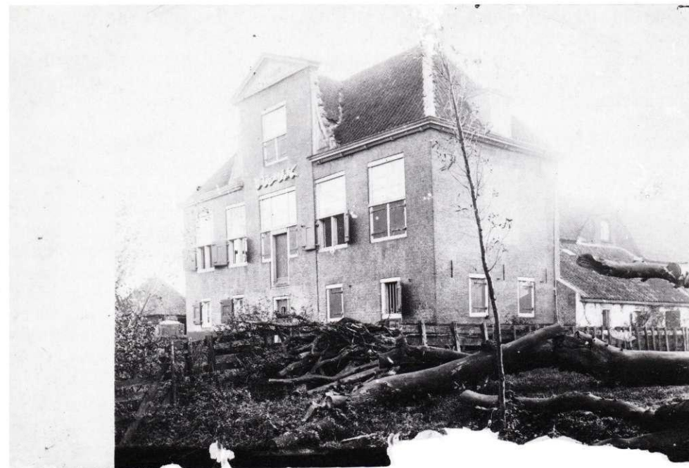
Ansichtkaart van de hofstede uit 1914, de oudst bekende afbeelding. Het 17e-eeuwse ornament boven de ingang op de verdieping is verdwenen en het dichtgezette venster in de rechterzijgevel is na de restauratie weer opengemaakt. Foto: collectie J. Groenewegen.
