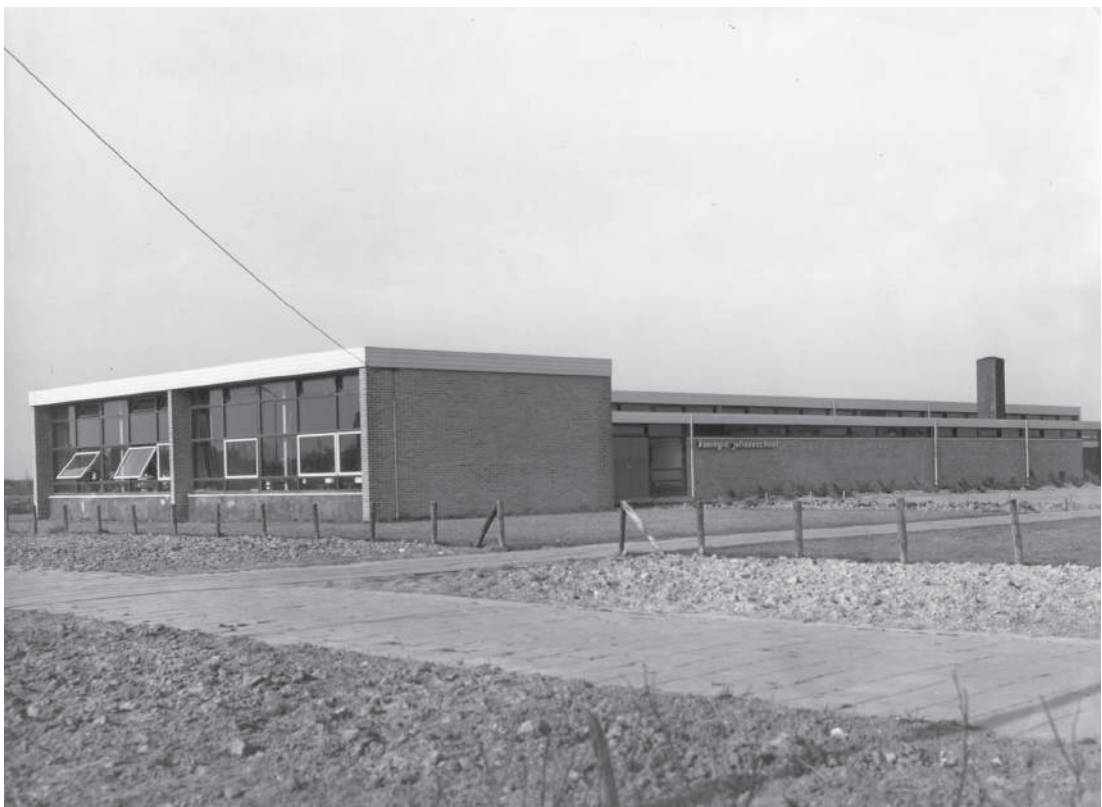
Tijdens de verbouwing van de Spaarbank tot 't Trefpunt werd 's zondags gebruik gemaakt van de aula van de Koningin Julianaschool aan de Dr. J.W. Paltelaan
