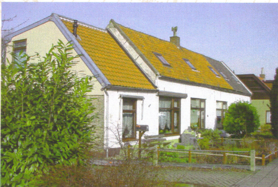
Kleine arbeiderswoningen uit de eerste decennia van de 20ste eeuw zijn tegenwoordig vaak ingrijpend verbouwd en vergroot.
