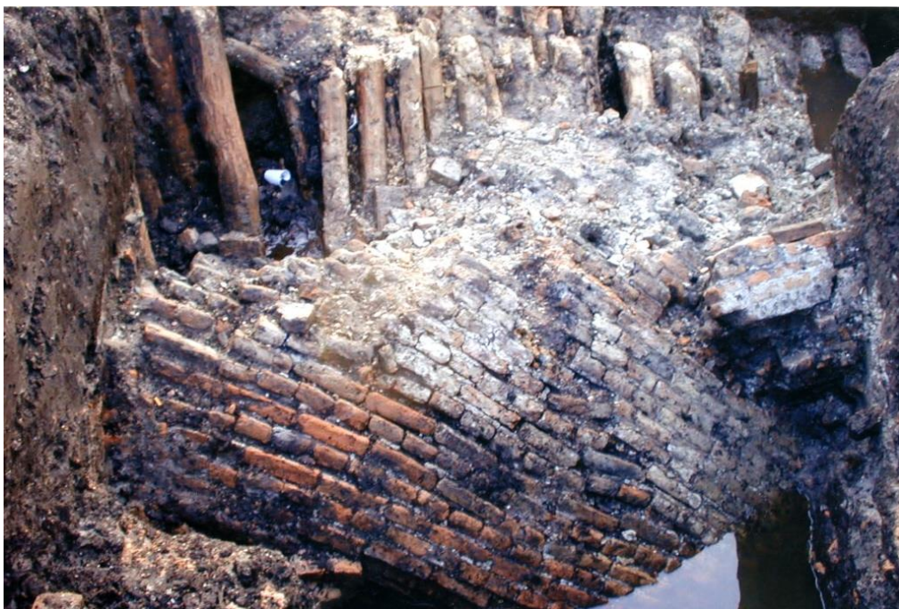
Resten van een fundering op palen en een omgevallen muur van Huis te Palenstein achter Dorpsstraat 110-112, gevonden door de Archeologische Werkgroep Zoetermeer tijdens een opgraving in 2000
