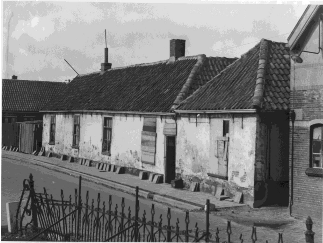
Delftsewallen 21-24 vlak voor de sloop, 1955. Rechts nog een klein stukje werkplaats nr. 25.
