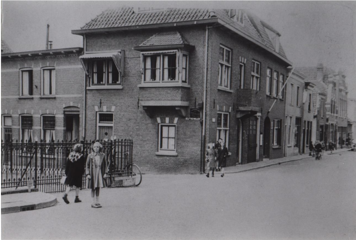
Het nieuwe pand Dorpsstraat 57, gebouwd 1935. Links Delftsewallen (29-)30.
