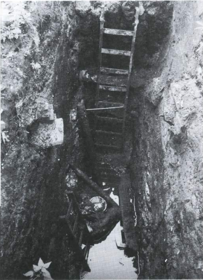
Om de fundamenteën van het Huis te Palenstein op te graven was een put van drie à vier meter diep nodig.
