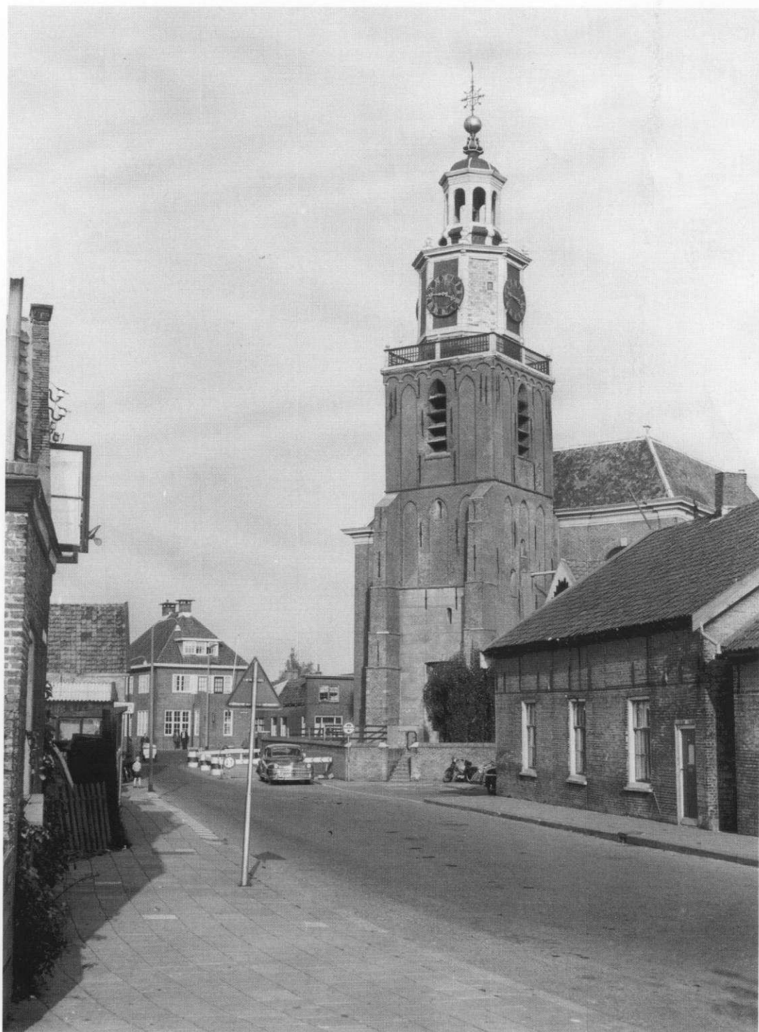
De toren voor de restauratie, omstreeks 1955.
