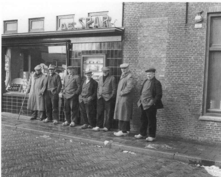
De strekken van een overbodig geworden venster van het voormalig kantoortje zijn in de zijgevel nog zichtbaar. (collectie: Gemeentearchief Rotterdam)
