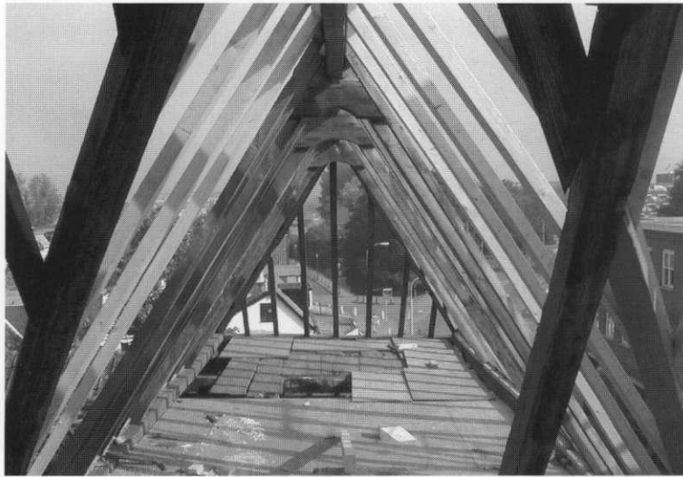
Herstel van de sporenkap. Bij de restauratie zijn de oude sporen zoveel mogelijk gehandhaafd. Onder de nokbalk bevinden zich zogenaamde spijkerplaten. (foto: mw B. Koopmans, Zoetermeer)
