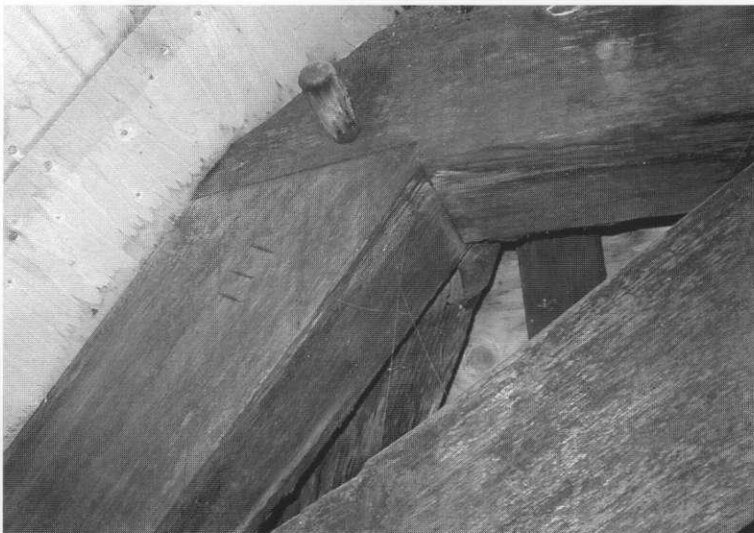
Pen-en-gat verbinding met een stevige houten toognagel. Daaronder is nog net het telmerk te zien; drie in het hout uitgekerfde streepjes boven elkaar. (foto: mw. B. Koopmans, Zoetermeer)
