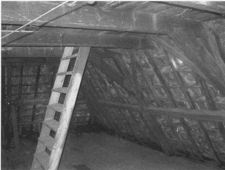
De constructie van de sporenkap met gebint, horizontale steunbalk, sporen en panlatten, waarop de aangesmeerde dakpannen liggen. Op het gebint rust de vloer van de vliering. Het kleine lichtpuntje rechts is van een dakpan met een ruitje. (foto: mw. B. Koopmans, Zoetermeer)
