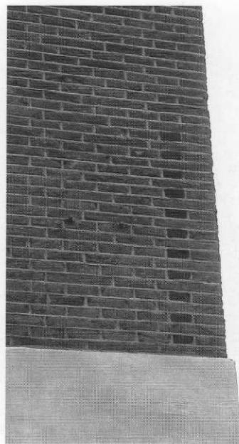
Vlak bij de hoek van de voorgevel zijn klezoren (kwart bakstenen) in het metselwerk verwerkt. (foto: mw. B. Koopmans, Zoetermeer)
