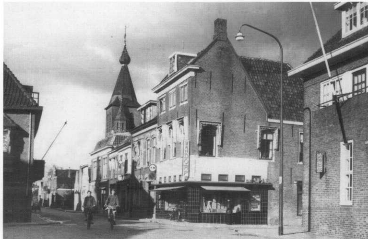
In 1956 werd de oude pui vervangen door een moderne gevel. De twee etalageruiten en de zwart geglazuurde tegels gaven de Spar-winkel een eigentijds uiterlijk. (foto: Fotobedrijf "Positief", Scheveningen; collectie: Historisch Genootschap Oud Soetermeer)
