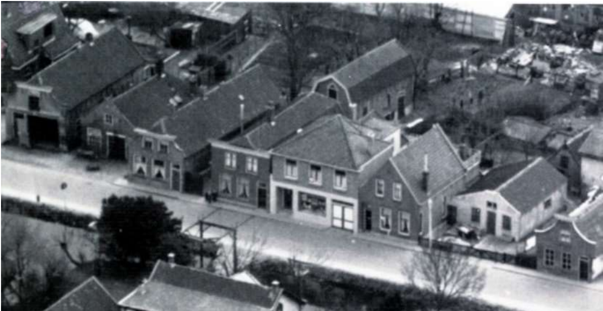
Vlamingstraat 19-21-23-25-27-29, 31 (schuur) en 33 (halsgevel)
