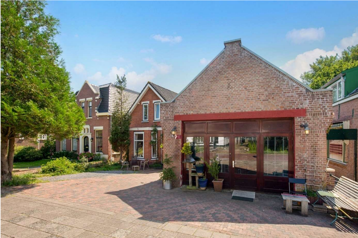
Werkplaats/schuur Vlammingstraat 63; de wagenmaker zou deze in 1923 verkopen aan de buurman van nr. 61
