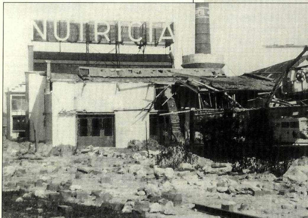
De zwaar beschadigde achtergevel van Nutricia na het bombardement van 30 maart 1945.
