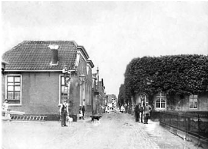
12. Het meest oostelijke gedeelte van de Dorpsstraat, dat het 'Lage end' werd genoemd. Blijkbaar moest de dakgoot gerepareerd worden. Op de hoek van het huis bevindt zich een gaslantaarn.
