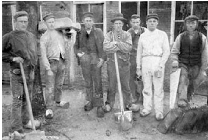
29. Hier wordt een huis gebouwd: in dit geval dat van M. van Pufelen aan de Voorweg. Te zien zijn onder anderen Albert van Dorp, Jan en Dirk Hartman, Tinus Vonk en Albert Muilwijk.
