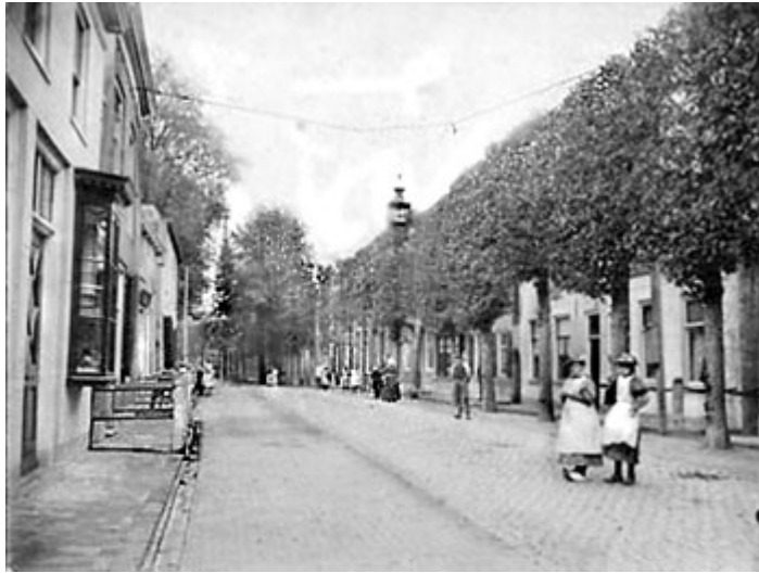
10. In de Dorpsstraat had ieder huis destijds een eigen stoepje. Lindebomen zorgden voor voldoende schaduw. Bakker Van der Boon stalde zijn waren in een fraaie vitrine uit.
