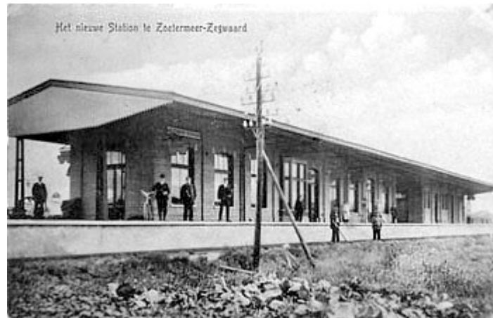
22. In 1904 brandde het spoorwegstation tot de grond toe af. Deze ansichtkaart toont de in 1906 herbouwde overkapping met de dienstgebouwen.
