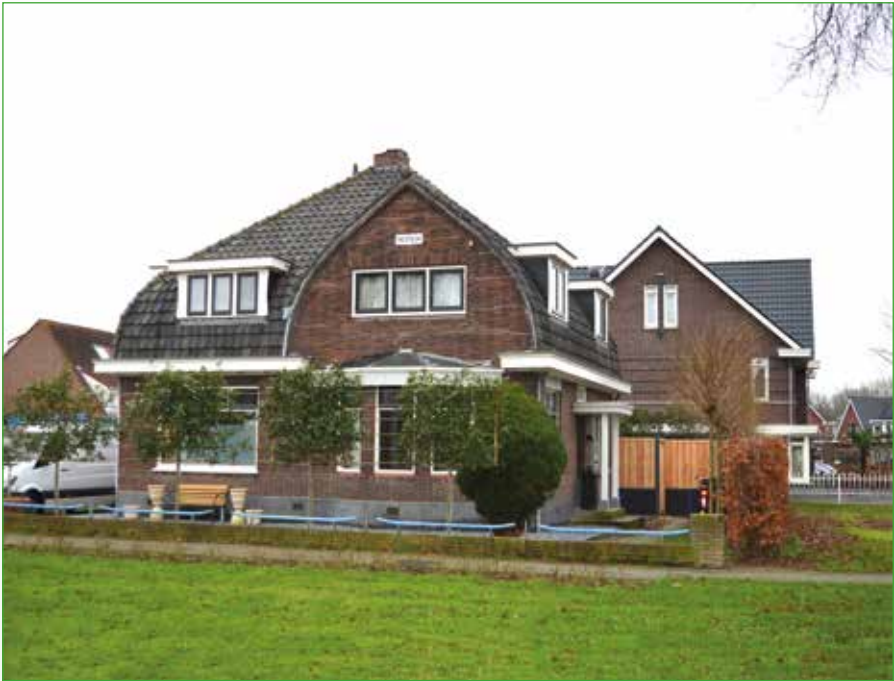
Villa Machtilda, 2e Stationsstraat 239, in oude luister hersteld. In 1930 in opdracht van tuinder Beukers gebouwd door architect J. van Vliet. Met zijn bolle dakvorm en de halfronde betonnen raamstijlen in de zijgevel doet het pand qua bouwstijl denken aan de Amsterdamse School. (Foto Arjen van der Burg)
