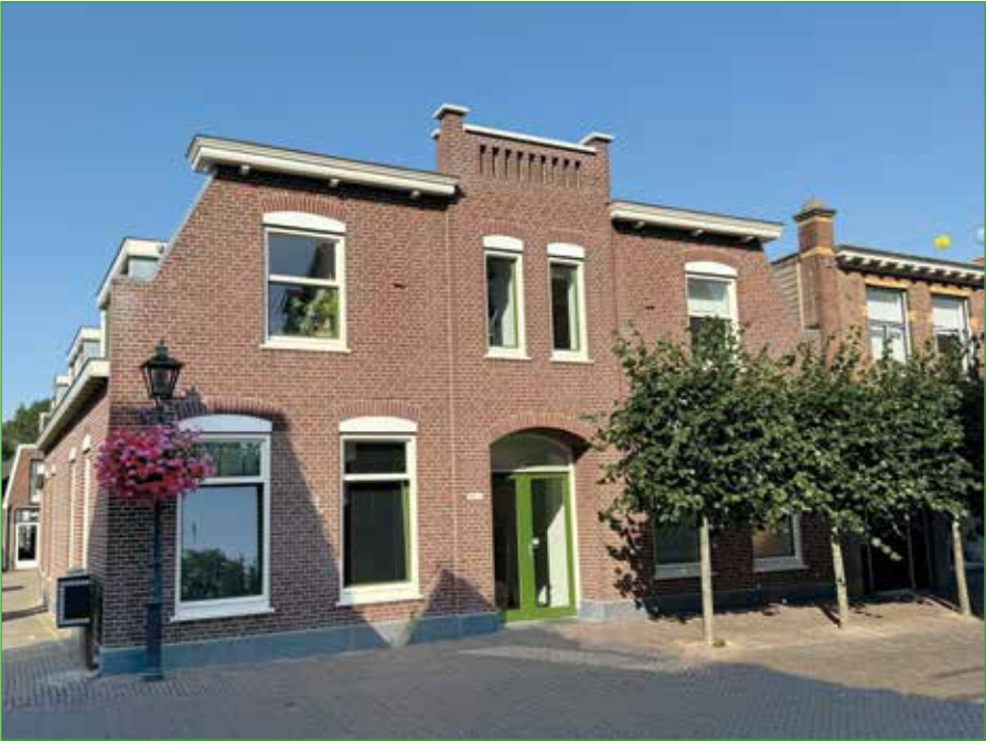
Dorpsstraat 152, terugbouwen van de oorspronkelijke gevel. Pand gebouwd in 1878, herbouwd in 1913. (foto Wouter Reitsma)
