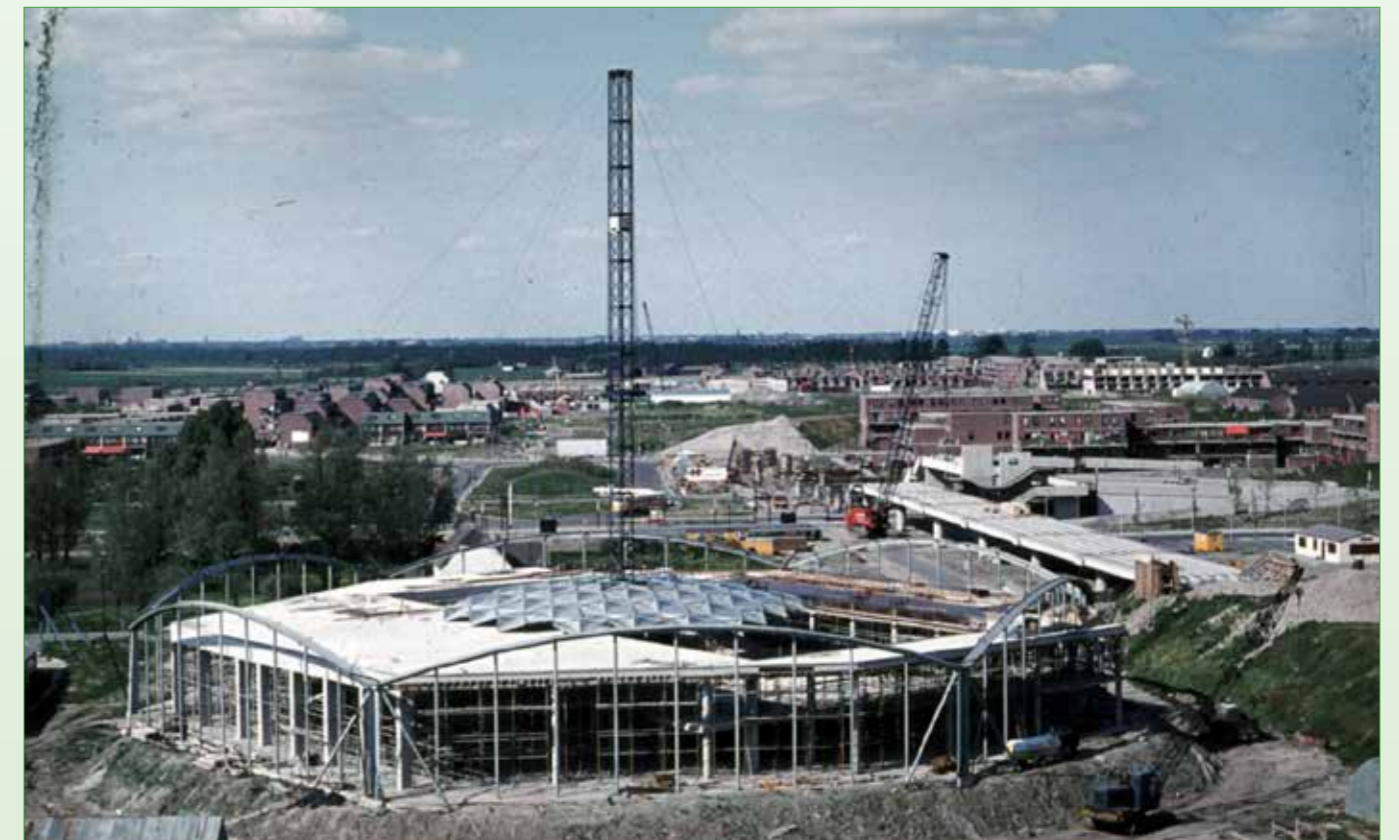
Figuur 10 De bouw van de sportkoepel rond de centrale mast
