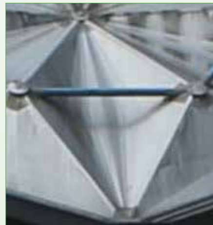
Koepелеlementen, een dubbellaags systeem: dak en detail (foto Dick Valentijn, bewerking Paul Schoenmakers)
