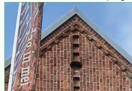
Staand metselwerk in Vlaams verband
