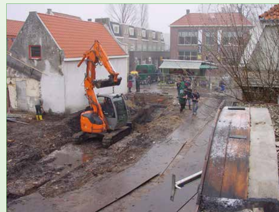
Een graafmachine werd ingezet voor de aanleg van een tweede sleuf. Het weer zat bepaald niet mee.
